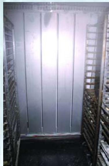
Die Druckwände in der TK-Zelle sind verstellbar.
