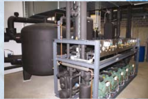
Der Technikraum erfüllt alle Sicherheitsvorschriften, die zum Betrieb einer Ammoniak-anlage einzuhalten sind.
