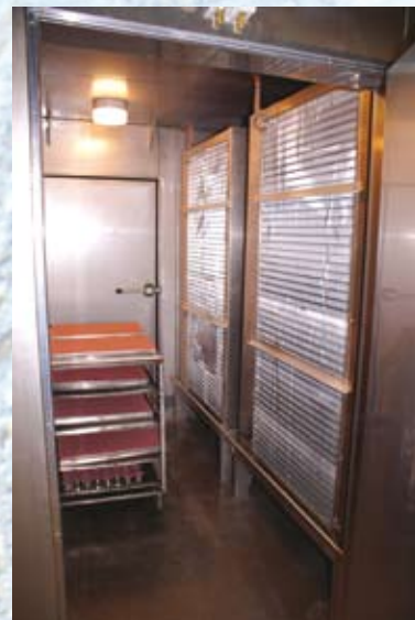
Der leistungsstarke Standverdampfer in der Schockzelle.
